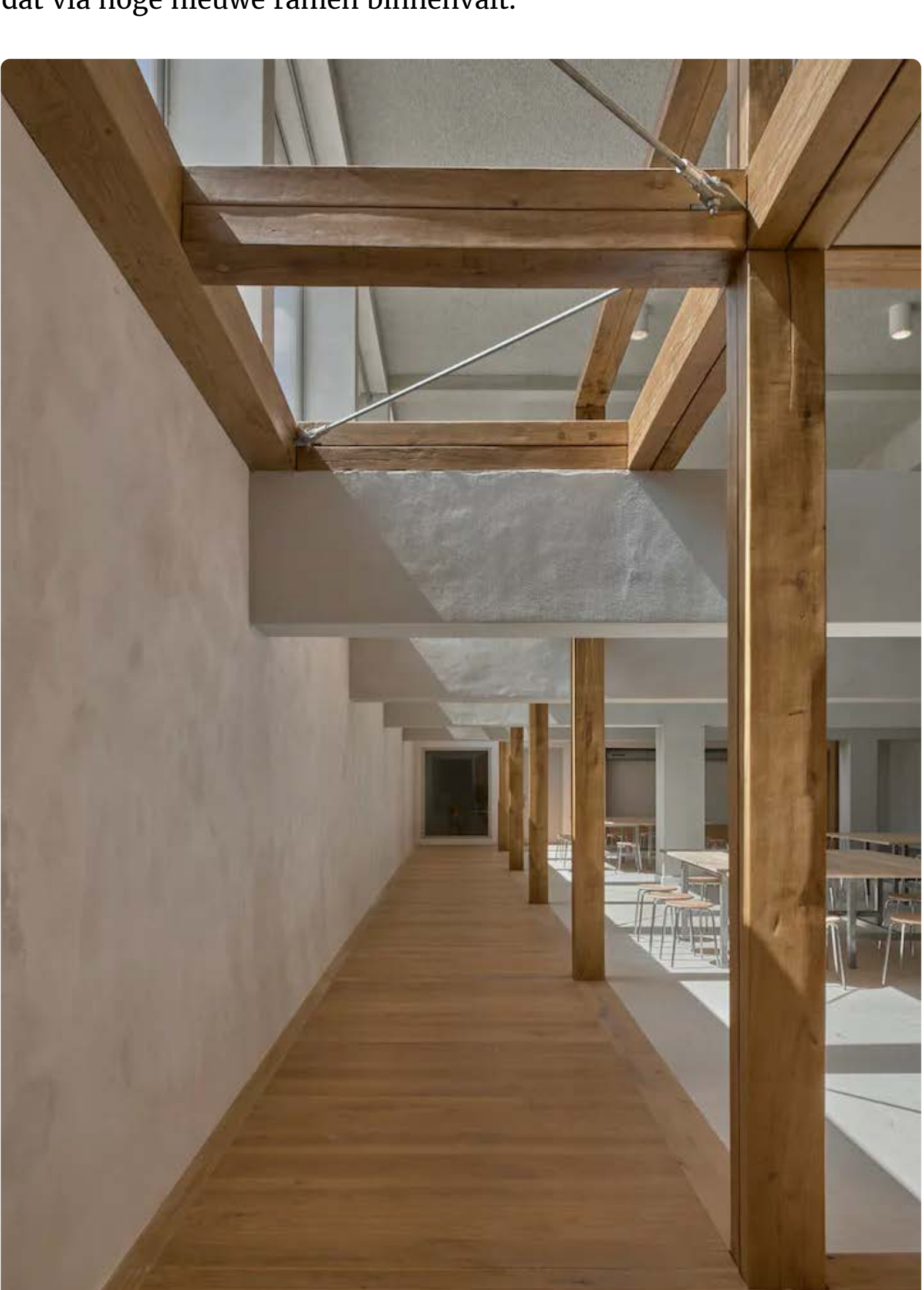
De houten constructie en windverbanden houden de kelderwand op zijn plek. Beeld MWA Hart Nibbrig
