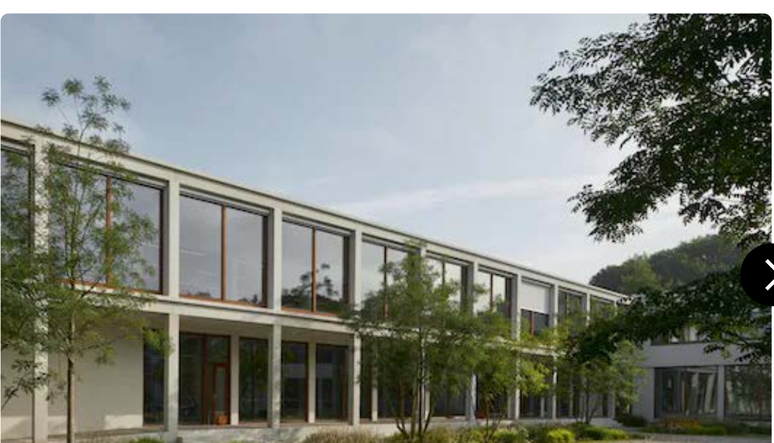
Een nieuw bouwdeel en plein verbindt de schoolgebouwen, gescheiden door een straat. Beeld MWA Hart Nibbrig
